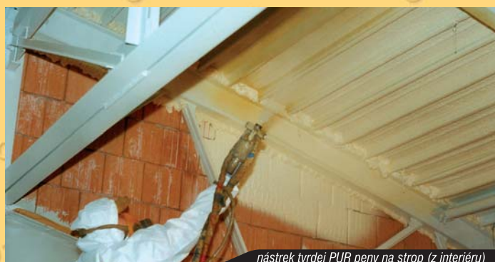
nástrek tvrdej PUR peny na strop (z interiéru)
