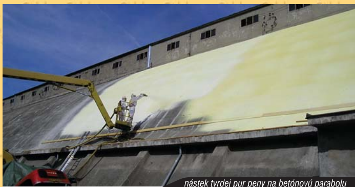
nástrek tvrdej pur peny na betónovú parabolu
