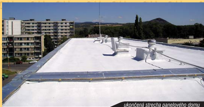
ukončená strecha panelového domu
