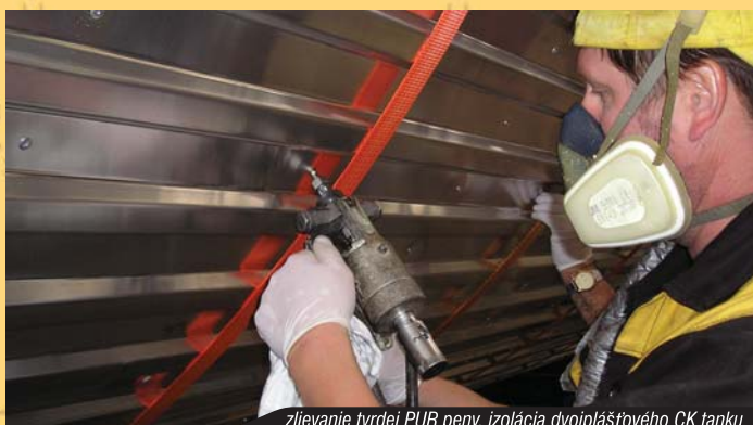
zlievanie tvrdej PUR peny, izolácia dvojplášťového CK tanku
