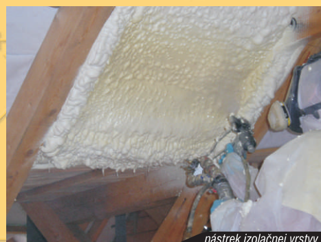
nástrek izolačnej vrstvy
