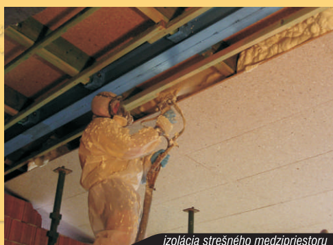
izolácia strešného medzipriestoru
