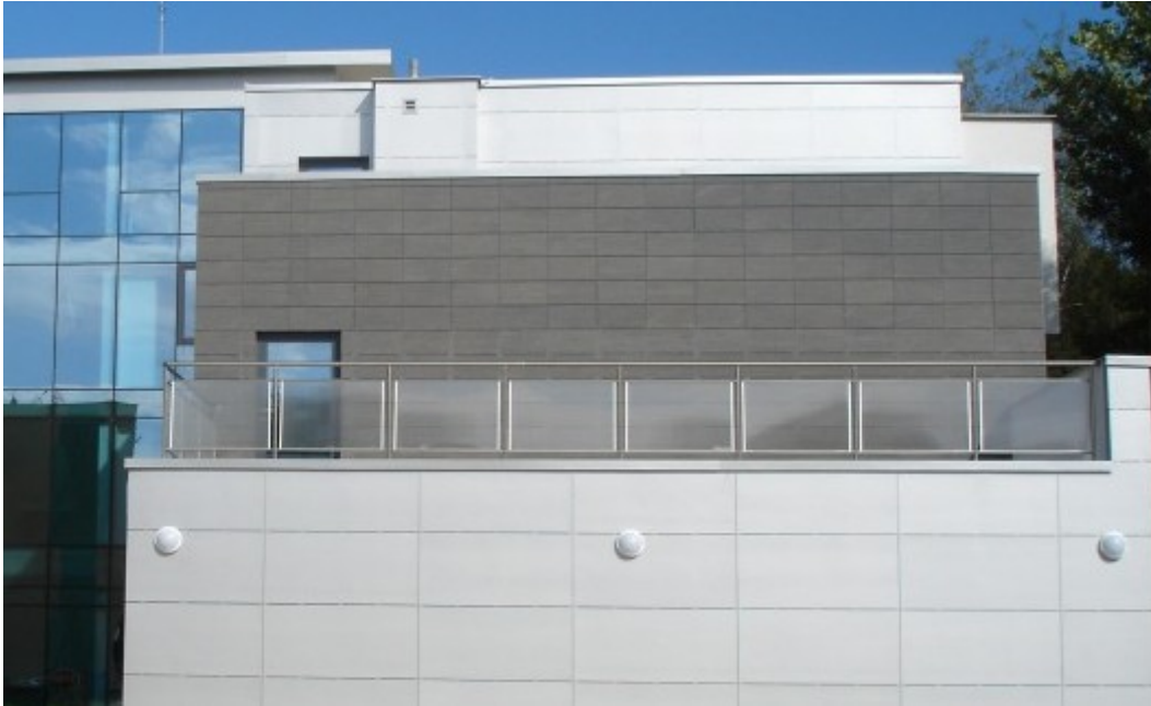
Obr. Zábradlie s lexanom
